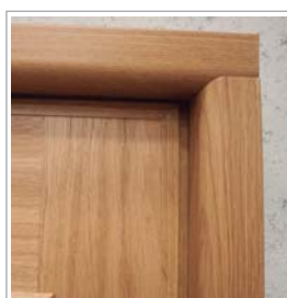
Detalle esquina cara exterior
